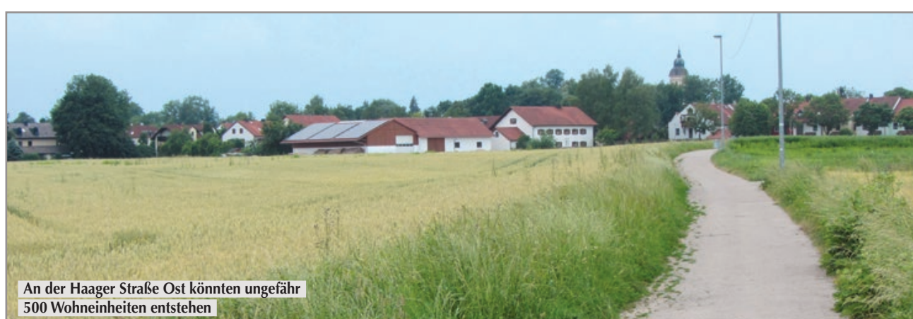
Westlich der Sandgrubensiedlung ruhen die Planungen. Der Bereich gilt als hochwassergefährdet
