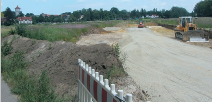
Die Erschließung des Poststadl-Geländes hat bereits begonnen
