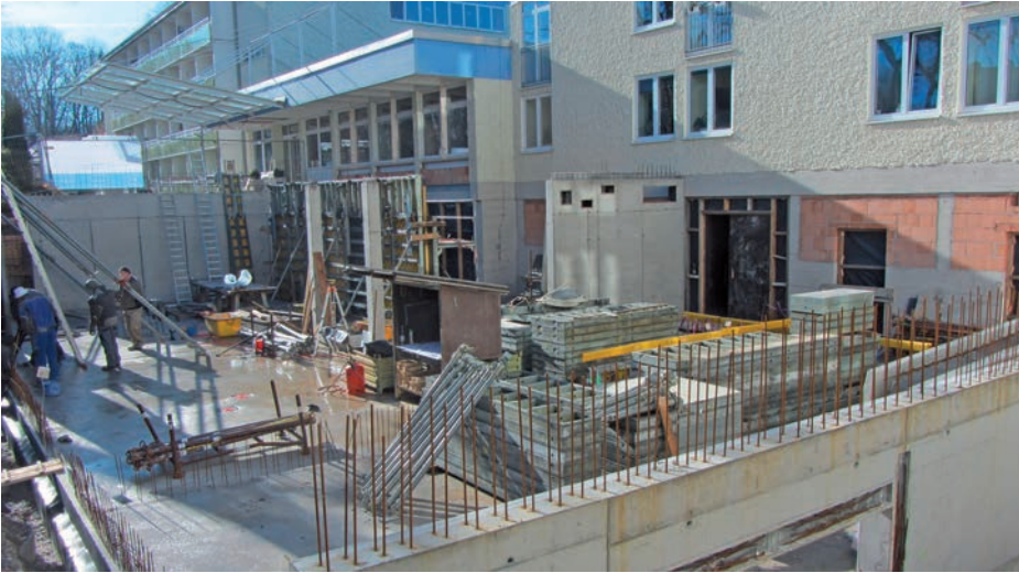
Der Küchenanbau ersetzt die bisherige Großküche an der Westseite des Altenheims.
